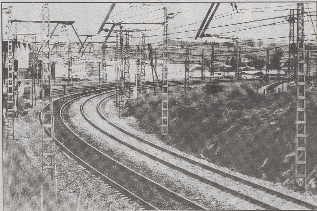
La rápida reparación de las vías afectadas permitió la reanudación del tráfico ferroviario en la misma tarde de ayer. ARCHIVO
