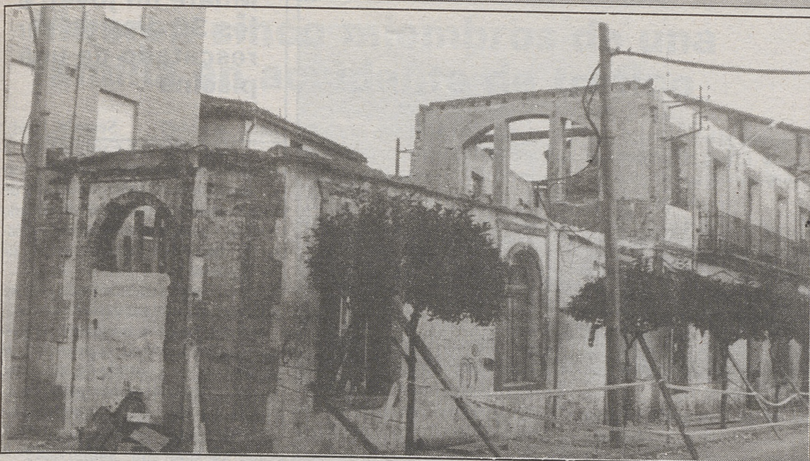
Otro casino sustituirá a este que es demolido.
