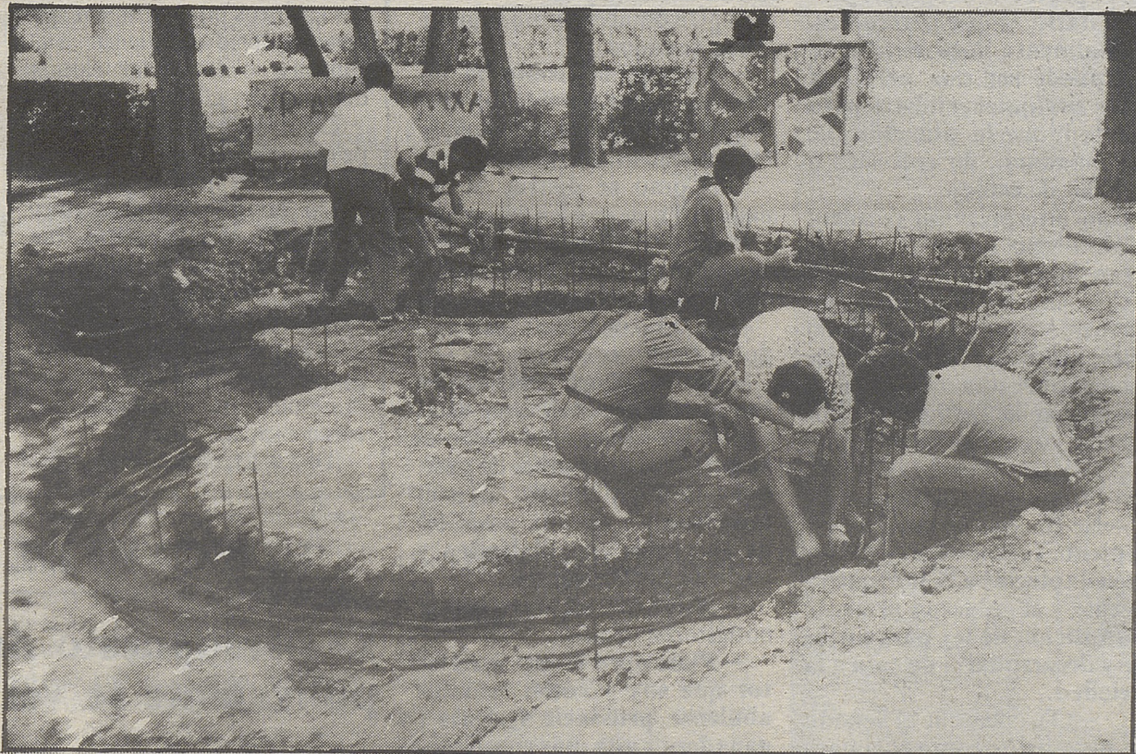
Los alumnos de la escuela construyendo la fuente hace unos meses
