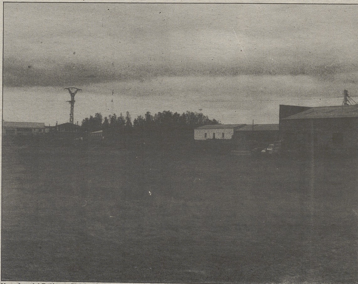
Una vista del Polígono Industrial de La Colilla.
