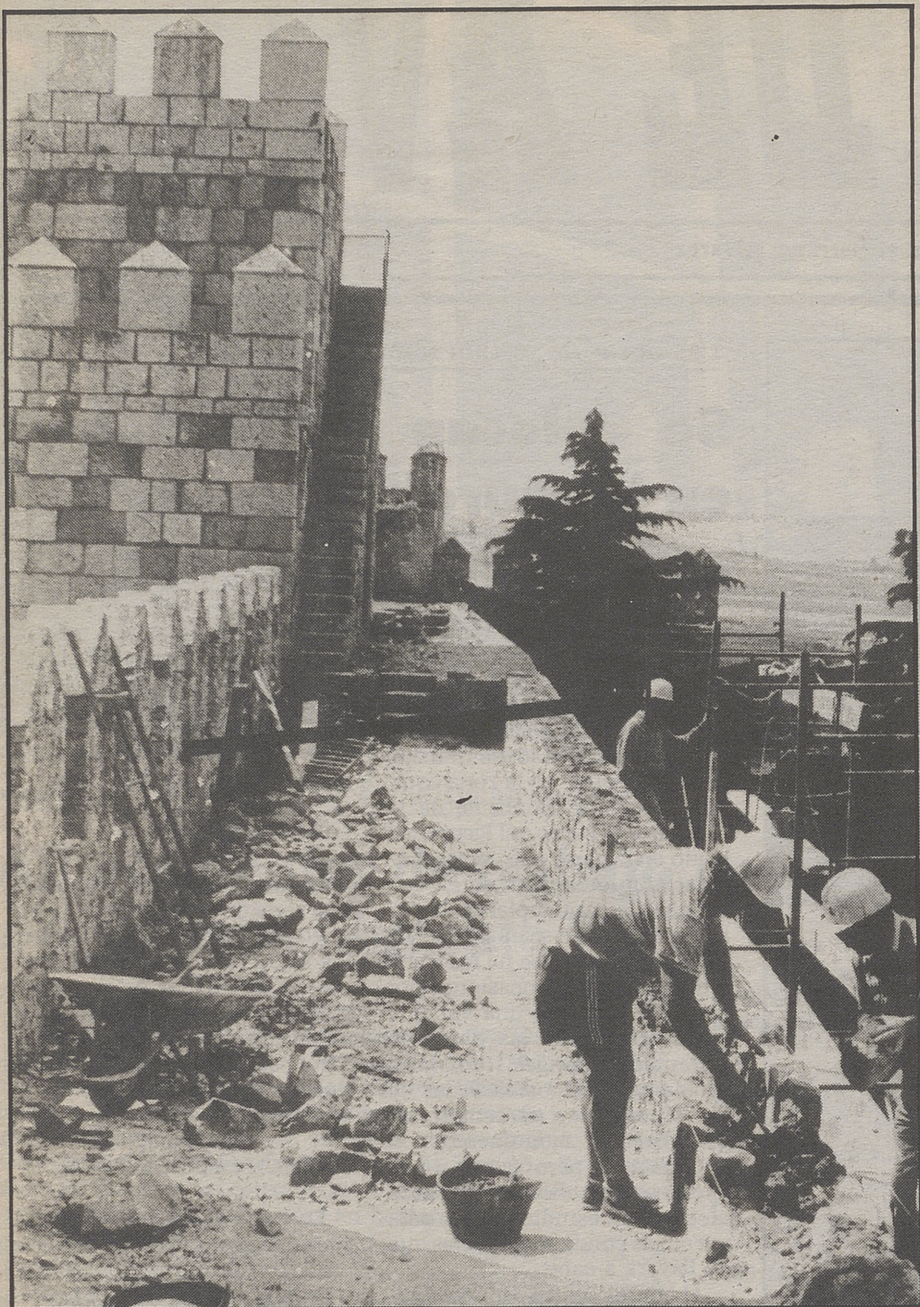
Murete de protección.
