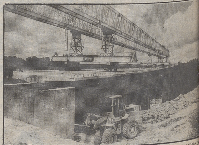
Las obras del puente siguen avanzando a buen paso
