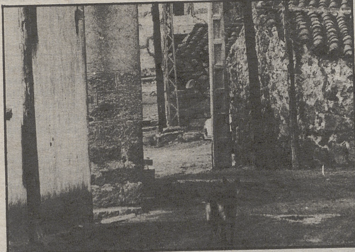
La pavimentación de calles, el capítulo de obras más grueso.
