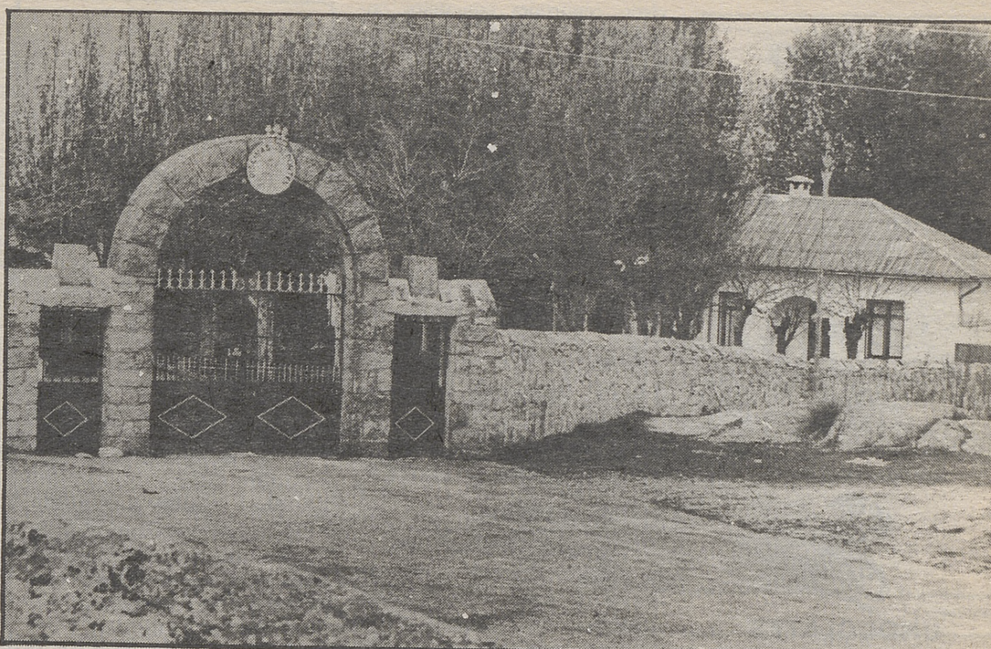
Entrada a las piscinas deportivas
