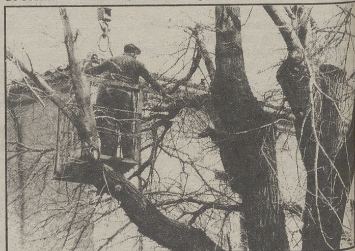
Ante la altura de los árboles, se empleó una plataforma que subió la grúa. LUMBRERAS
