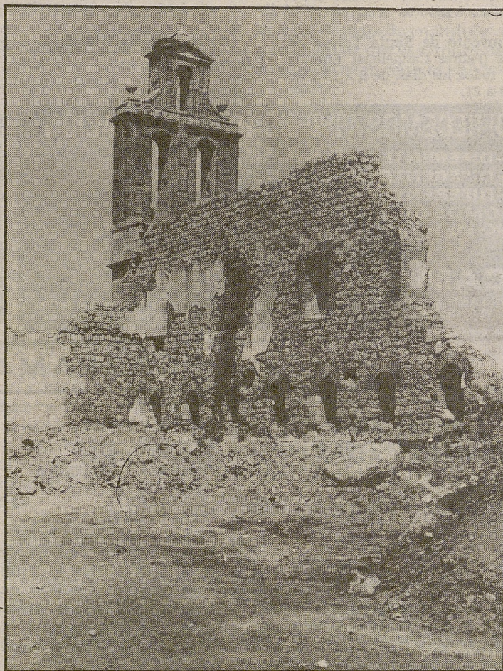
Las obras que se realizan en el antiguo convento de San Jerónimo, han dejado al descubierto los restos del único muro que queda LUMBRERAS
