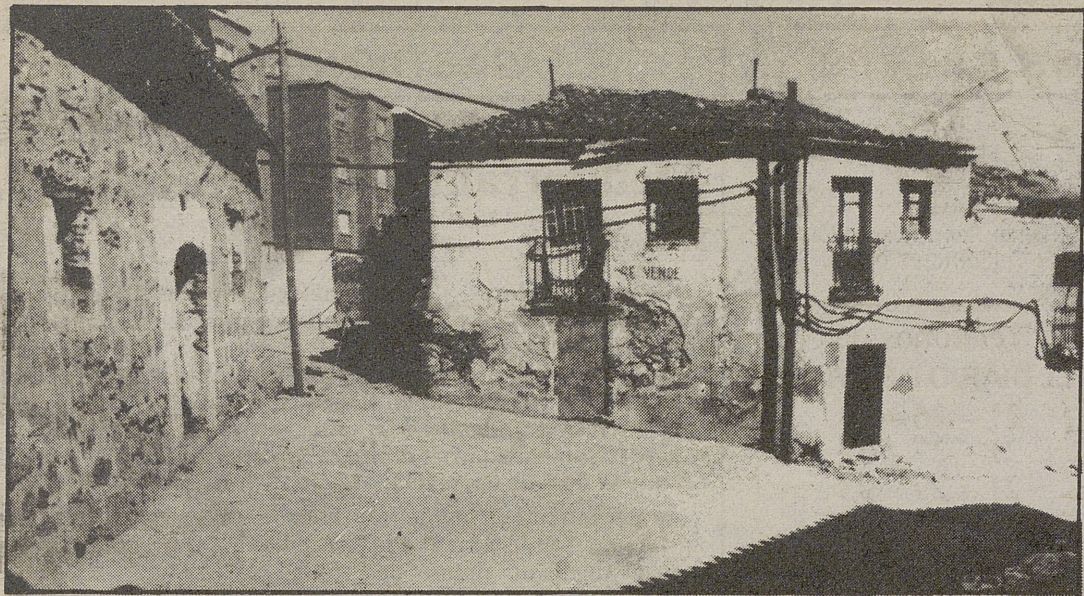
El arrabal absorbido y encajonado entre zonas nuevas del casco urbano.
