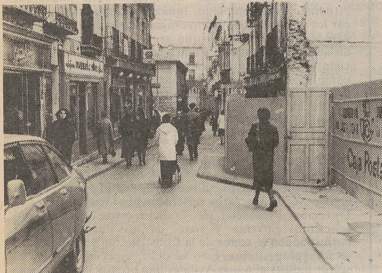
La calle Reyes Católicos, de por sí bastante estrecha, ha visto disminuida la anchura de su calzada, al ser ocupada por una obra. Se trató de una calle conflictiva, ya que a la estrechez de su calzada, por la que discurre la circulación rodada, debido a su ubicación en la zona comercial, se encuentra siempre ocupada por numerosos peatones. (Foto: LUMBRERAS)
