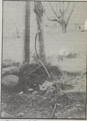
No parece que el cable, con unos empalmes al alcance de cualquier mano, que desde el poste baja al suelo quedando en parte al descubierto, sea precisamente un ejemplo de seguridad y buena instalación. Se encuentra en la carretera de Burgohondo, cerca de la estación de servicio allí existente. (Foto: LUMBRERAS)
