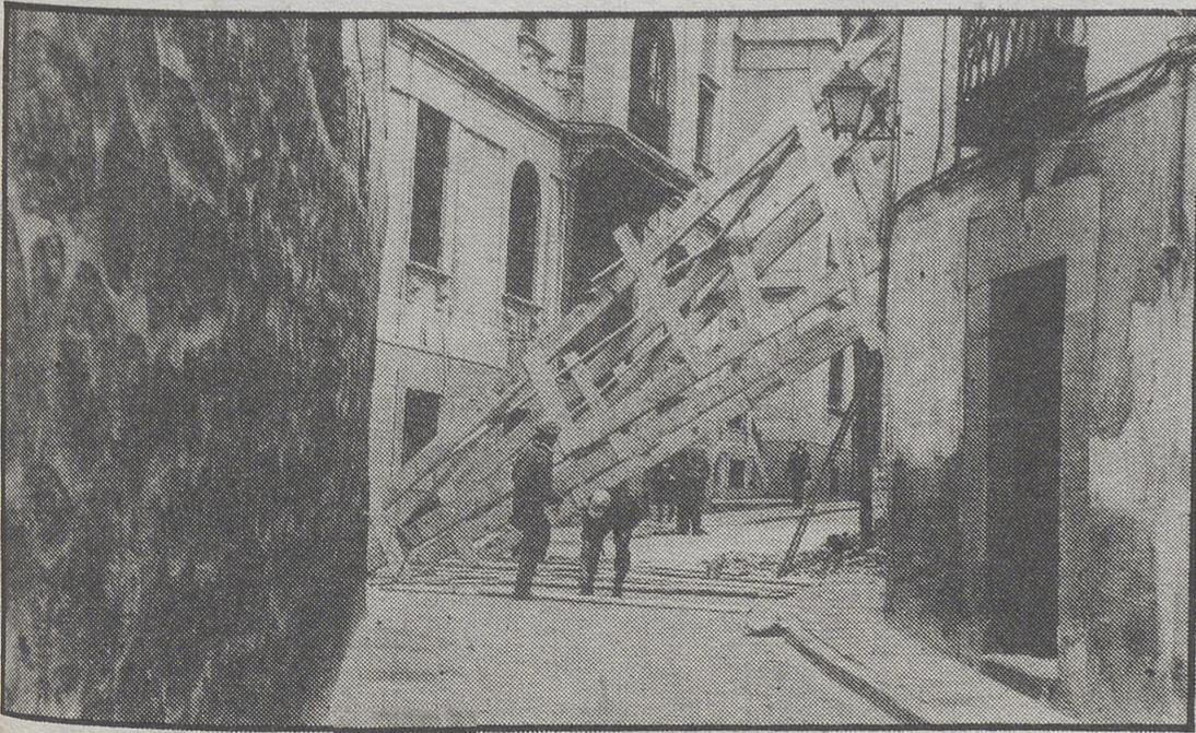
La calle Esteban Domingo ha quedado cortada al tránsito rodado (como informábamos en nuestra edición de ayer) debido a los puntales de madera colocados para evitar el derumbamiento de una fachada. Según quedó reseñado, anteaer se derumbó un muro en una vivienda colindante con el solar en el que se llevan a cabo las obras de deribo de un viejo inmueble, previas a las de construcción de un nuevo edificio.
