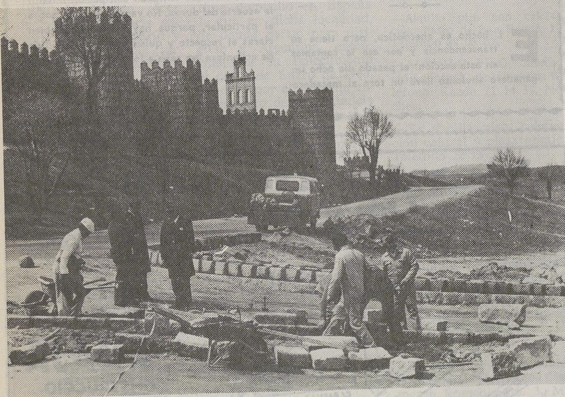
Pronto quedará completamente terminada la instalación de bordillos a todo lo largo de la «Ronda», obra en la que desde hace algún tiempo se trabaja intensamente. Con estos bordillos se pretende lograr una mayor seguridad en esta vía, puesto que por ese lado solamente accederán a ellas los vehículos que salgan de los accesos procedentes de la «Ronda Vieja». Constituirán, además, un motivo ornamental, ya que parece que en ellos se colocará un seto, en toda la longitud de ese tramo de carretera.
