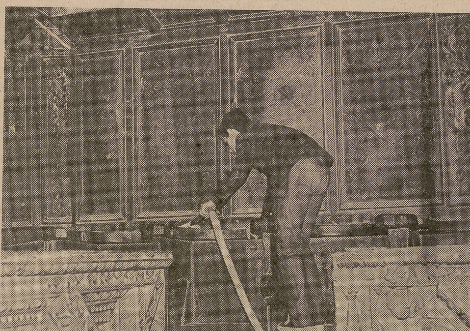
Limpiando la recién descubierta sillería
