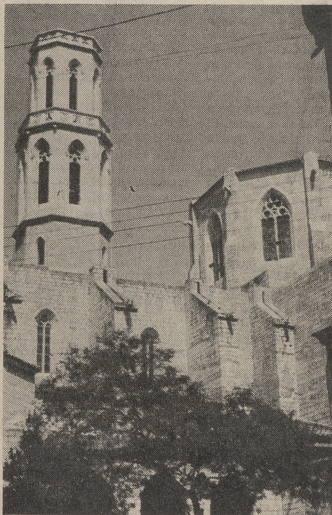
La Parroquia de Figueras, construida en el siglo XVI, quedó destruida casi completamente. De la calidad de la reconstrucción, efectuada por el Estado después de 1940, da fe esta imagen.
