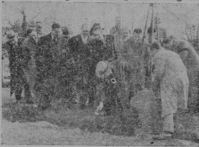
El Alcalde de Palma Sr. Coll Fuster echando las primeras paladas de tierra sobre la primera piedra que se bendijo y colocó ayer del grupo de Viviendas benéficas que construirá el Ayuntamiento en El Rafal. — (Foto Reportajes Palma).
