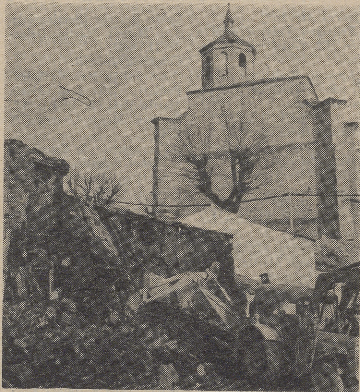
La torre de la iglesia de Santiago, a cuyos pies se extiende la barriada, fue ayer "espectadora" de excepción de los trabajos de demolición.—(Foto: MAYORAL).
