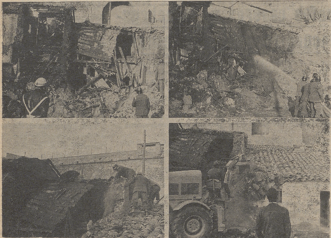
Cuatro momentos de los trabajos de derribo de las tres viviendas del barrio de "Las Covachuelas" ayer desaparecidas. En algunas ocasiones, el agua que soltaba la manguera de los bomberos era suficiente para echar abajo un muro.—(Foto: LUMBRERAS).
