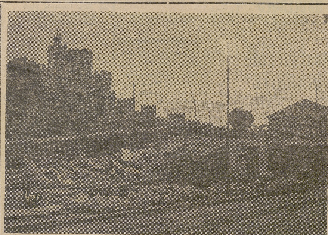
Desde hace unas semanas, se están llevando a cabo en la Avenida de Madrid las obras de demolición de los antiguos cocherones de Obras Públicas que, con su presencia, obstaculizaban la vista de la muralla. En muchas ocasiones nos hemos referido a la conveniencia del traslado de estos talleres y, una vez efectuado éste al nuevo parque construido en la carretera de Madrid, fuera del casco urbano, no se han hecho esperar los trabajos para dejar libre la vista de ese lienzo de nuestro primer monumento.—(Foto: LUMBRERAS).
