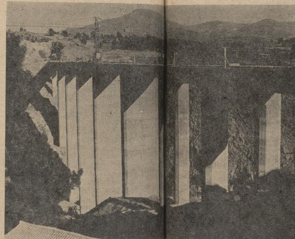
Vista total del viaducto por cuyo fondo discurre el río Cofio. Pueden observarse en la parte superior derecha del puente las pilas gemelas dispuestas para ser mon-
