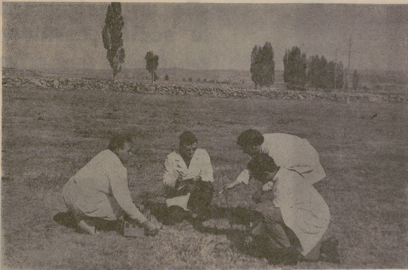
UN PROYECTO: BUSCAR AGUA.—Equipo técnico de sondeo eléctrico para detectar agua en el subsuelo.
