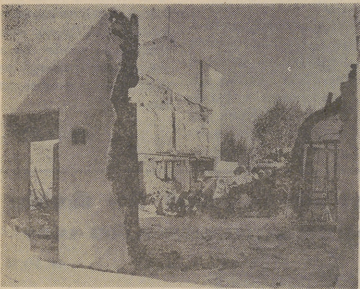
III.—Solar de Cáritas Diocesana en la calle de San Juan de la Cruz, donde se levantará un nuevo edificio de tres plantas dedicado a los servicios asistenciales, órganos de gestión, e instituciones dependientes de Cáritas. Será como la Casa Central de toda la Acción Caritativa y Social que la Iglesia desarrolla en la Diócesis. Los trabajos de descombro ya han comenzado.
