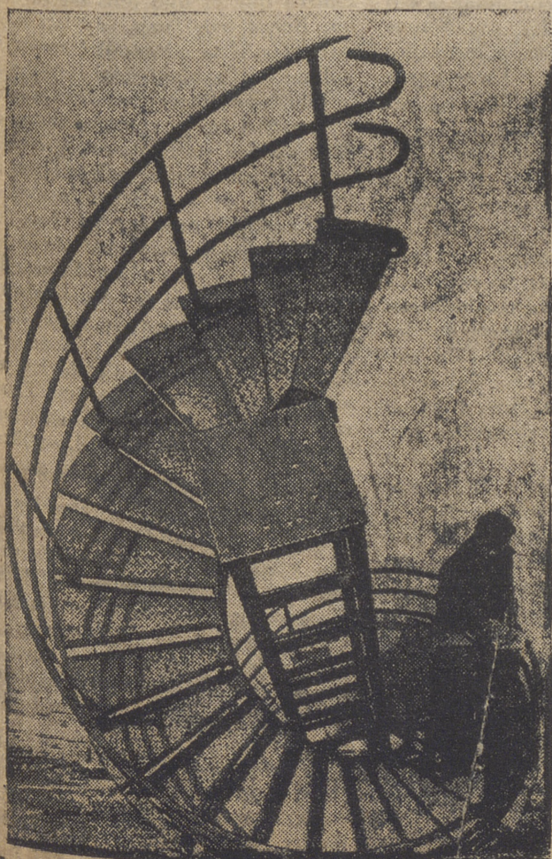
Un obrero trata de subir por la escalera de caracol que será instalada en un nuevo faro que se construye actualmente en Dungeness.
