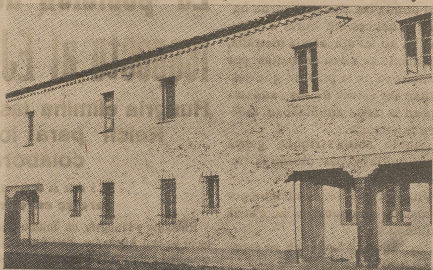
Una casa del grupo de viviendas para labradores y obreros agrícolas, construido por el Ayuntamiento de Dueñas, en la provincia de Palencia.—(Foto S. O. F.)
