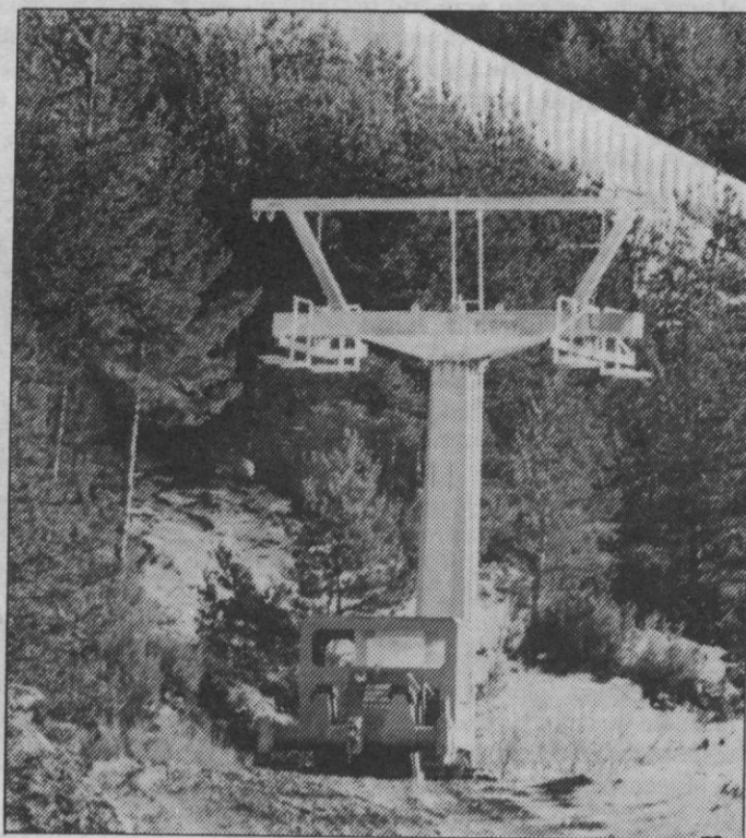
Los esquiadores se golpearon con una de las pilonas del remonte.
