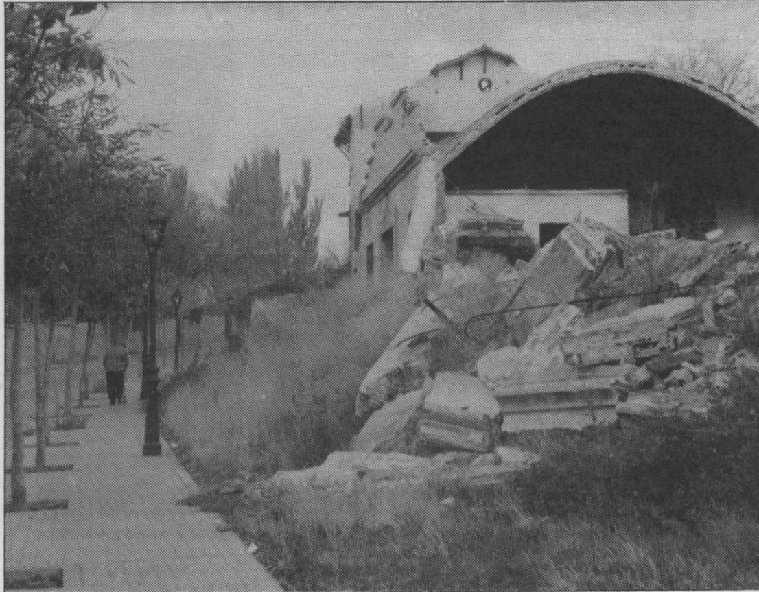
La situación de ruina de las edificaciones constituía un grave peligro para los vecinos de la zona. M. GALINDO
