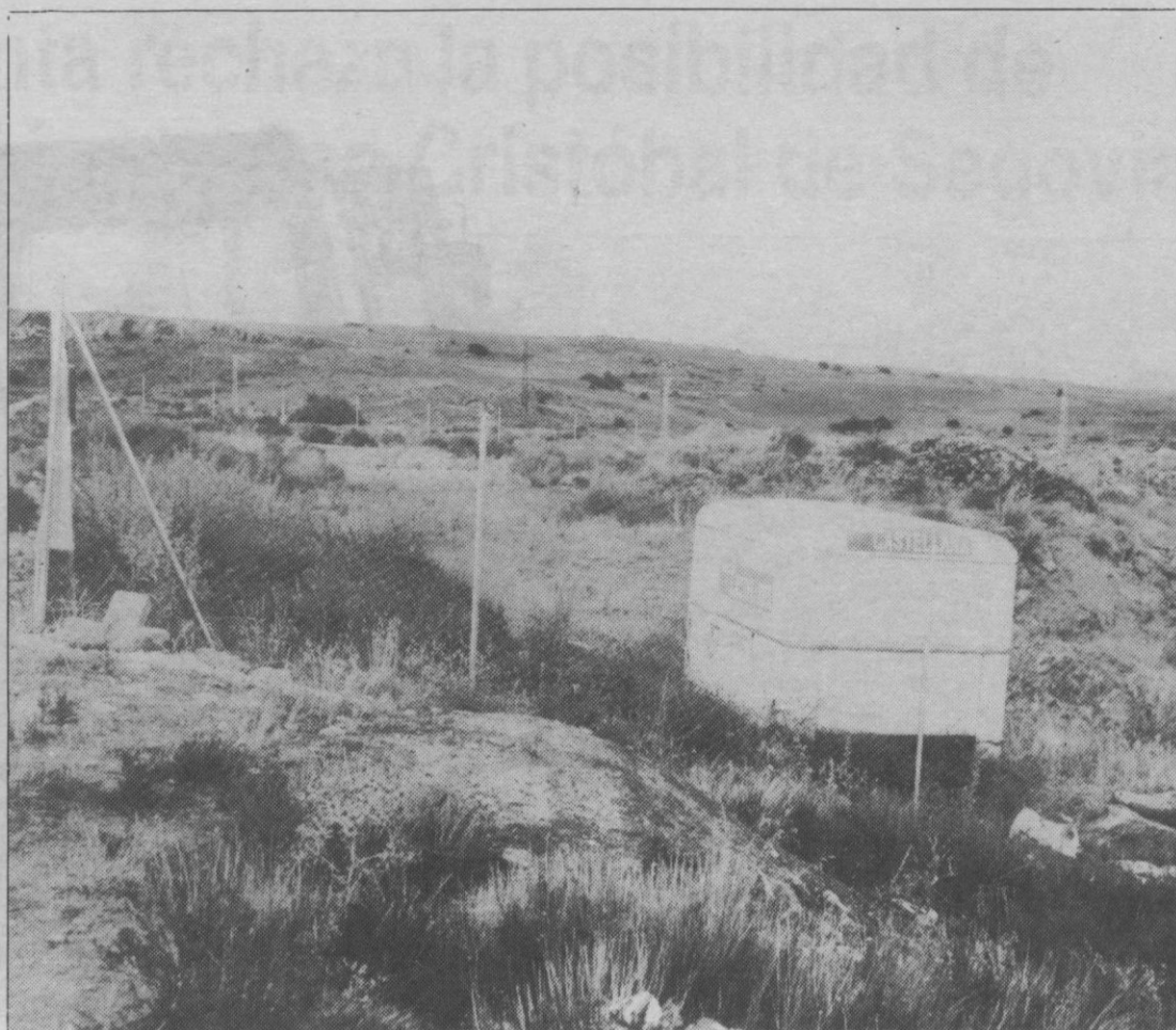
La empresa confía en iniciar las obras en su parcela en un corto espacio de tiempo.
