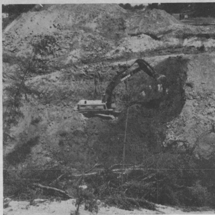
Obras de la variante en el "Puente segoviano".
