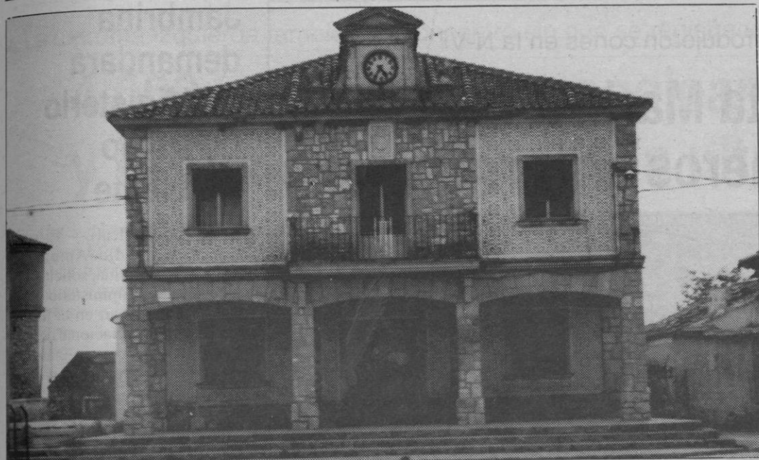
Fachada principal de la Casa Consistorial de la localidad de Rebollo.
