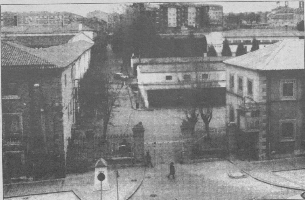
La Academia de Artillería realizará algunas obras antes de abrir al tráfico Coronel Rexach.
