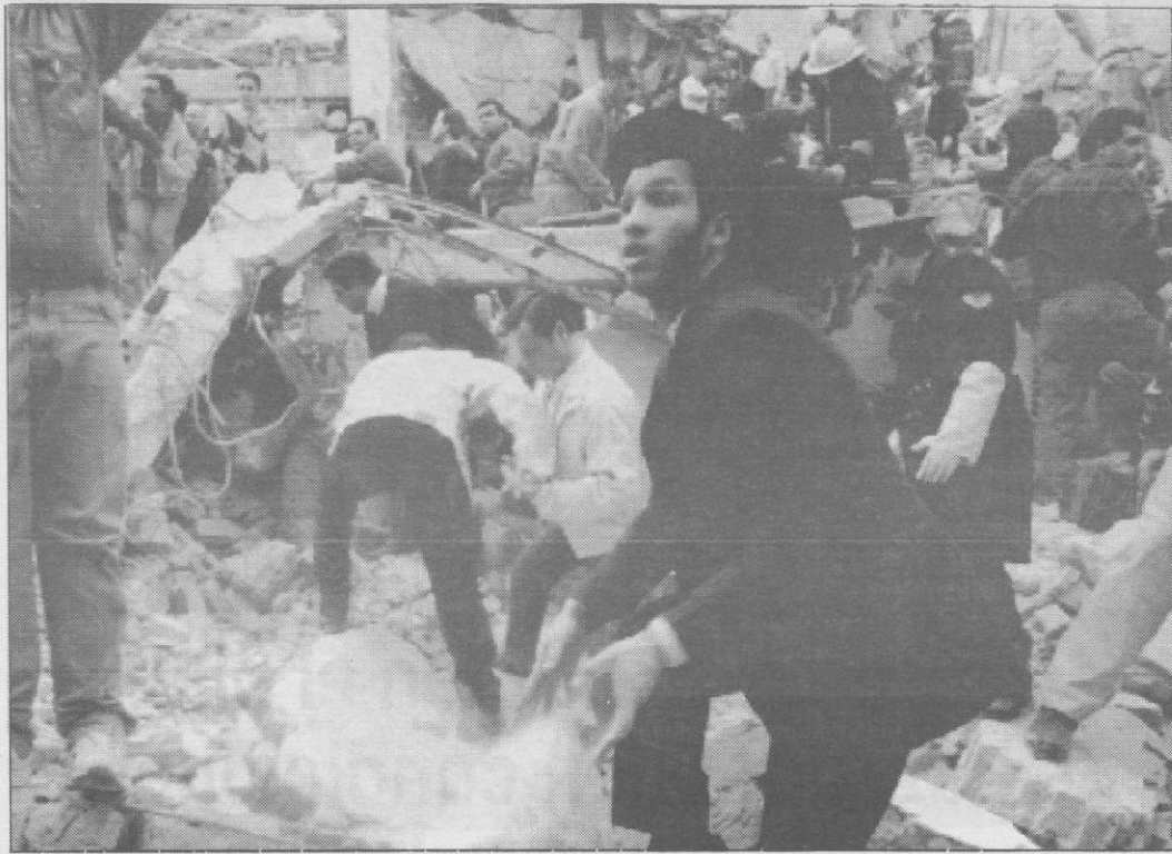
Los equipos de rescate continuaban ayer buscando víctimas entre los escombros.
