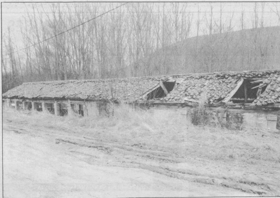
Las obras no van a modificar el aspecto antiguo del lavadero de Santa Cruz.
