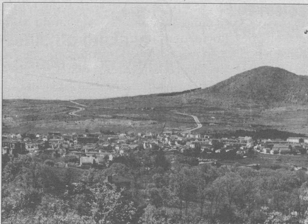
Telefónica instalará una base de telefonía móvil en la localidad de El Espinar.
