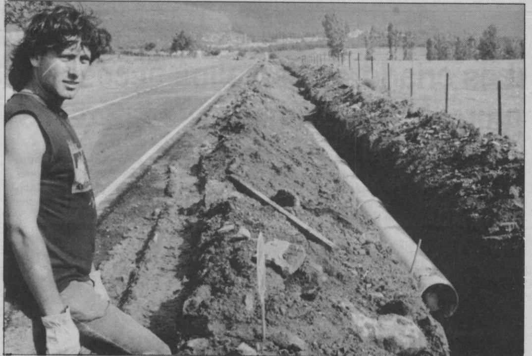
Obras de entubado del agua del río Cambrones.
