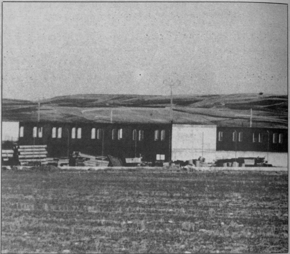
Asuntos Penitenciarios quiere reanudar el proyecto de edificación de la cárcel de Perogordo. Pero ahora, además, quiere duplicar, al menos, la capacidad solicitada por el Ayuntamiento de Segovia.
