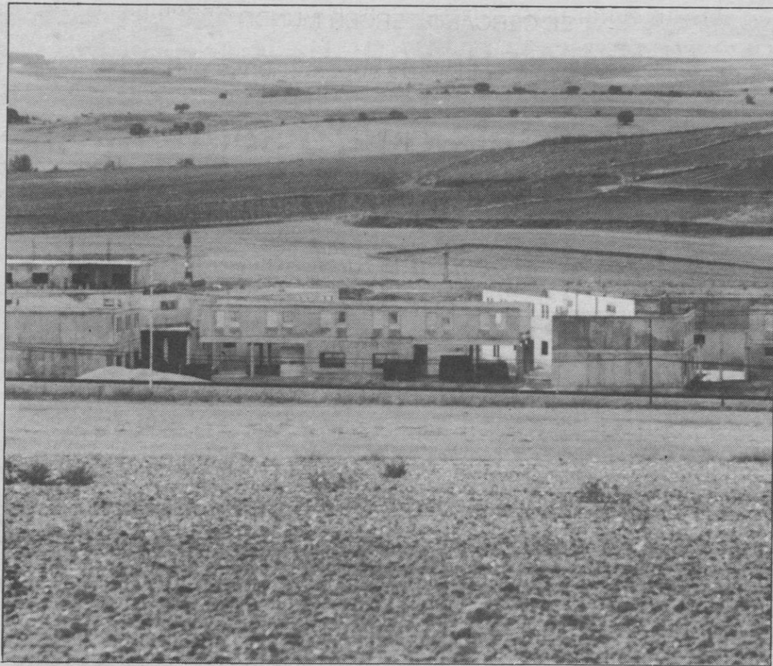
El centro penitenciario de Segovia, en término de Perogordo, permanece con las obras paralizadas. PEÑALOSA
