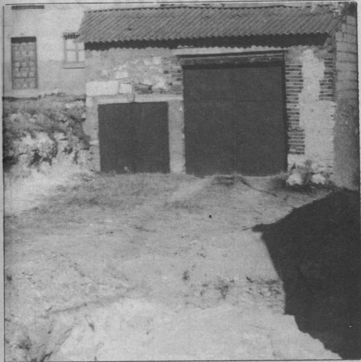
Zona en la que se ha descubierto la cimentación de la muralla.
