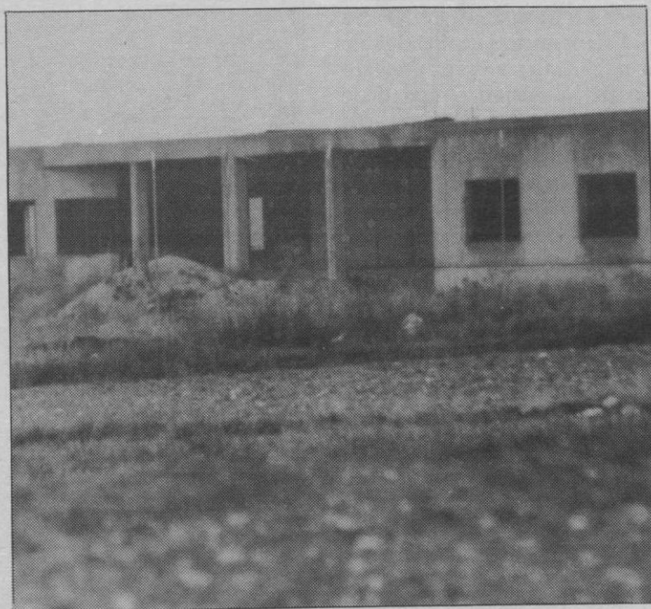
Obras de la nueva cárcel, ahora paralizadas, en Perogordo M. GALINDO
