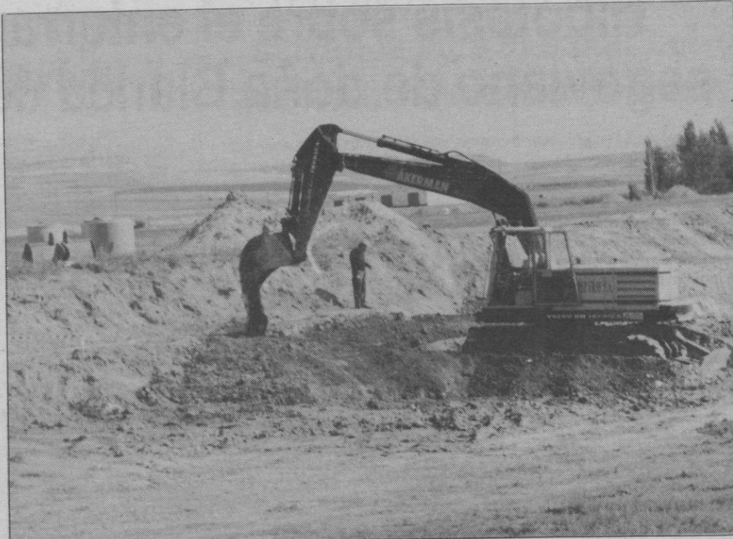
Obras de canalización junto al río Cerquilla
