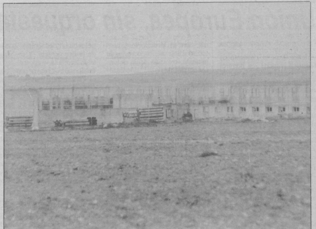
La ampliación está prevista llevarla a cabo sobre lo ya construido en Perogordo.
