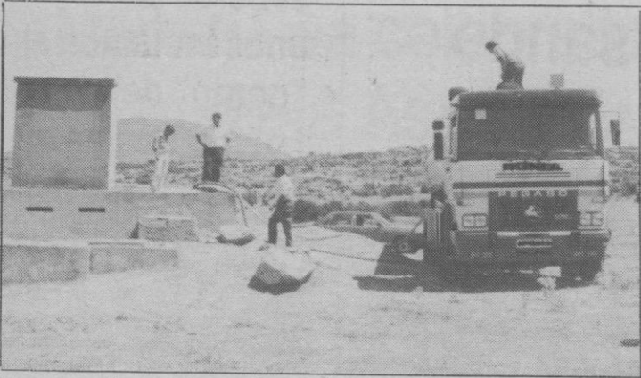
Hace unos años camiones cisterna llenaban el depósito
