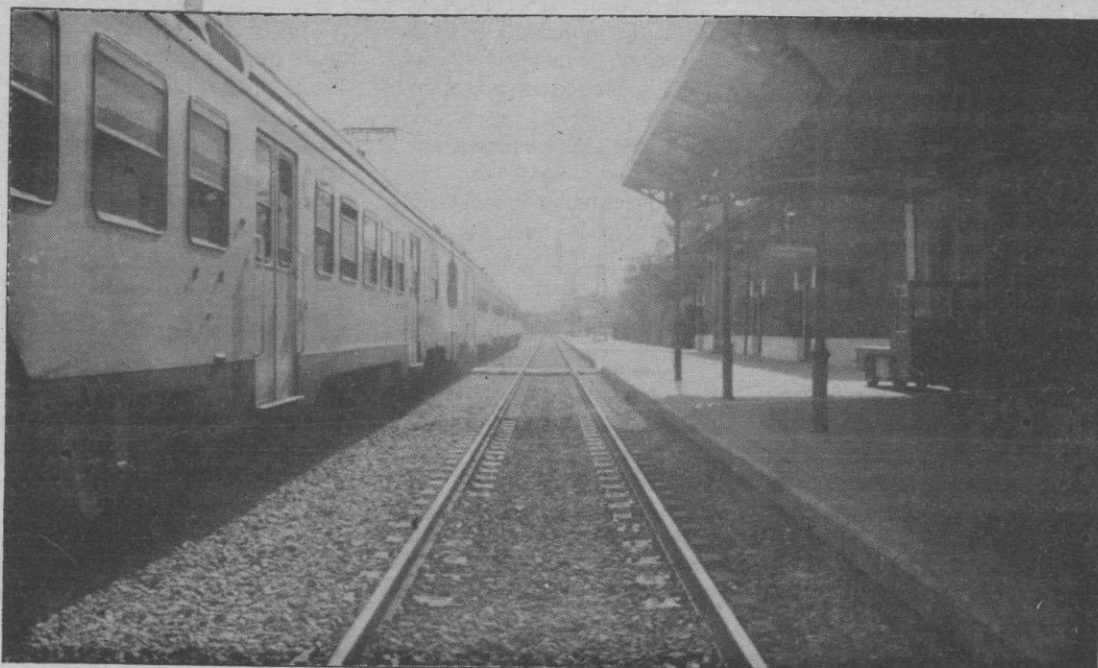
También se construirá un paso a nivel para los viajeros.
