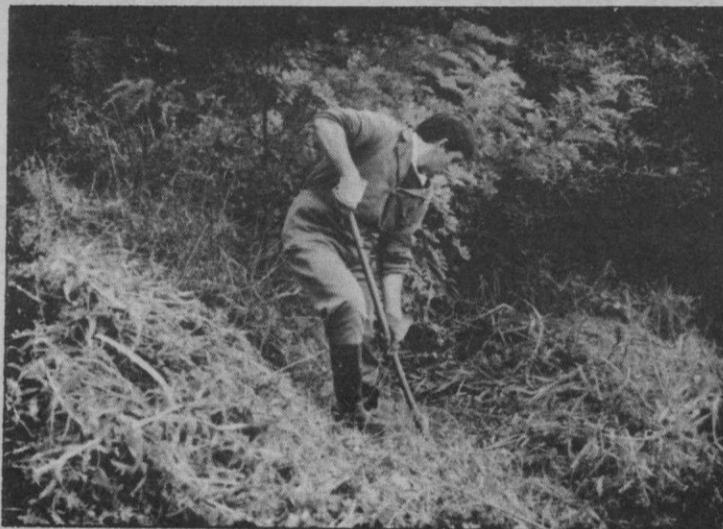
Las márgenes del Ciguñuela serán rehabilitadas por el taller
