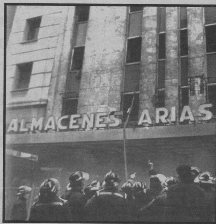
Una deficiente estructura en llamas acabó con la vida de varios bomberos y de los tradicionales almacenes Arias. FOTO: EFE
