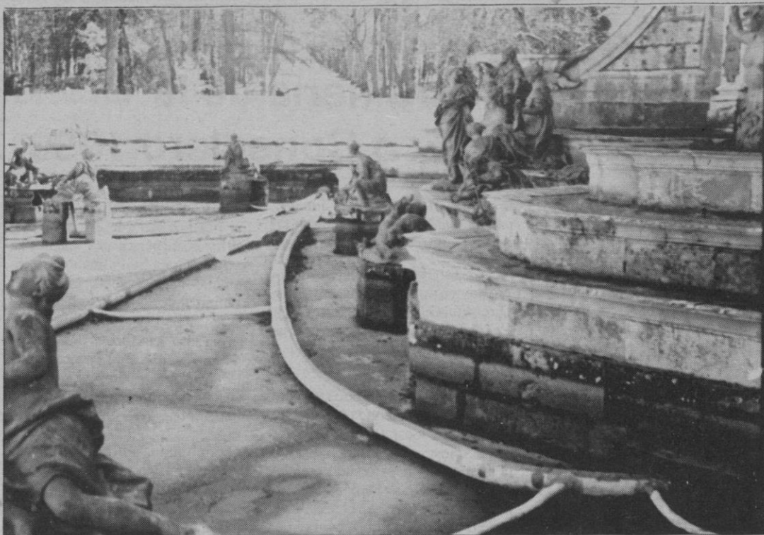
En el vaso vacío se pueden ver las viejas y las nuevas conducciones
