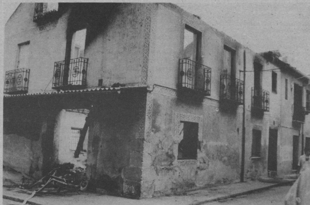
Del edificio tan solo quedan en pie las cuatro paredes
