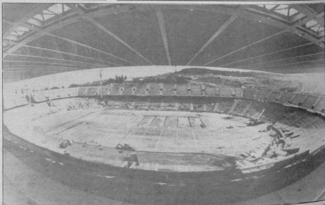
Barcelona.—Estado actual de las obras del Estadio Olímpico de Montjuïc, donde ya se ha retirado la maquinaria pesada y van muy avanzado el drenaje del campo de césped y pista de competición.—(Telefoto Efe)
