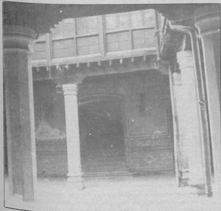
Patio de la Casa de los Picos, antes de la restauración
