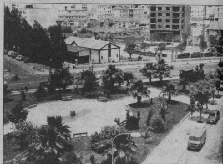
Las instalaciones ferroviarias, convertidas en lugar de recreo para los niños.
