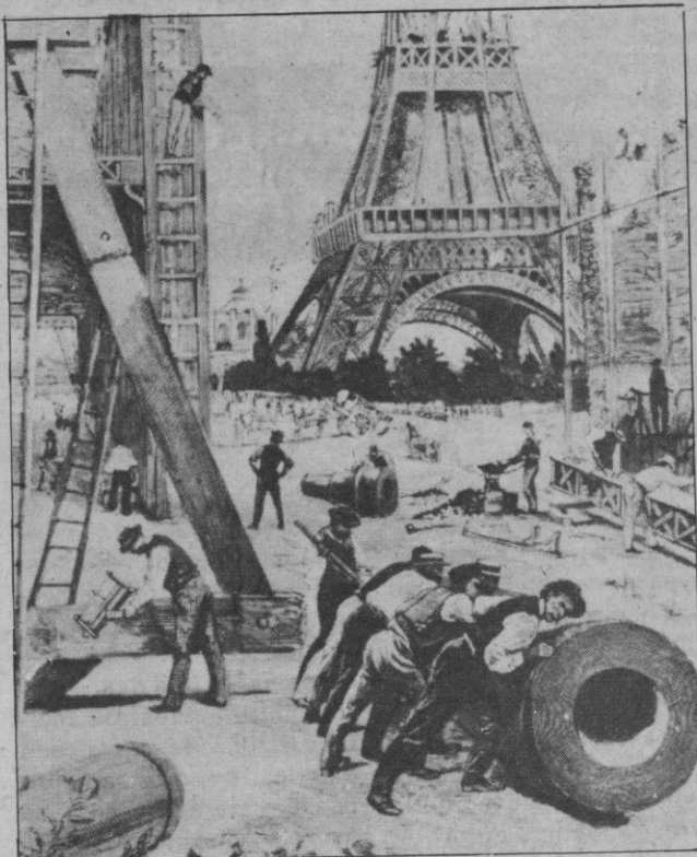
Una vista de los trabajos en 1888
