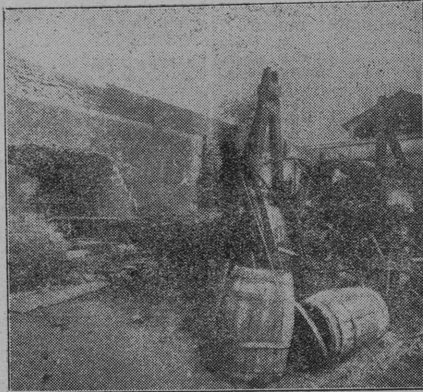
Barcelona. — Estado en que quedó el almacén de los señores Llagostera y Pelat, sito en la calle de Vilasar, barriada de la Bordeta, después del incendio que lo destruyó totalmente y en el que pereció carbonizado un hombre.
