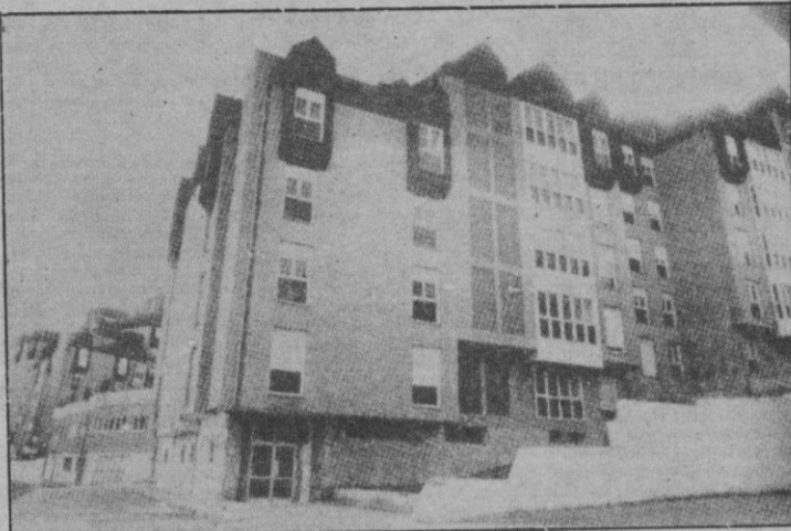
Complejo de viviendas de Algorta-Guecho, destinadas a familias de miembros de las fuerzas de seguridad del Estado, en cuyo interior fueron encontrados cincuenta kilos de goma-2.
