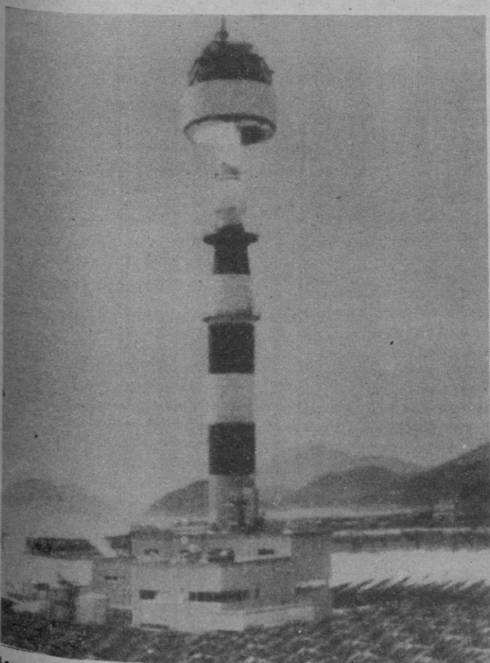
Acumulando rayos solares reflejados en 807 paneles perfectamente coordinados, el aparato de concentración de calor de la torre central desprende luz sobre el cielo de la Planta de Energía Solar Nii, (en japon)
