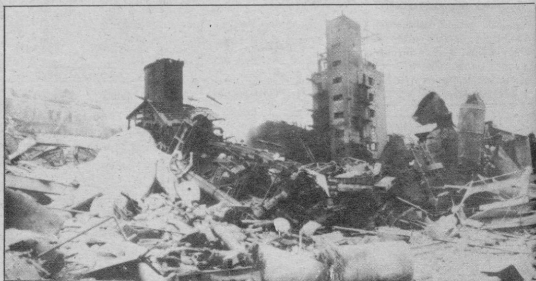
Copenhague.—Cinco muertos y unas veinte personas heridas fue la consecuencia de una explosión registrada en el departamento de material técnico de una fábrica de soja en esta capital, como informamos ayer. Partes del edificio quedaron totalmente destruidas y en edificios próximos a la fábrica se rompieron los cristales de ventanas y escaparates. La explosión despertó a la mayor parte de la población de Copenhague, ya que el hecho se registró a primeras horas de la madrugada.—(Telefoto Efe/Upi)
